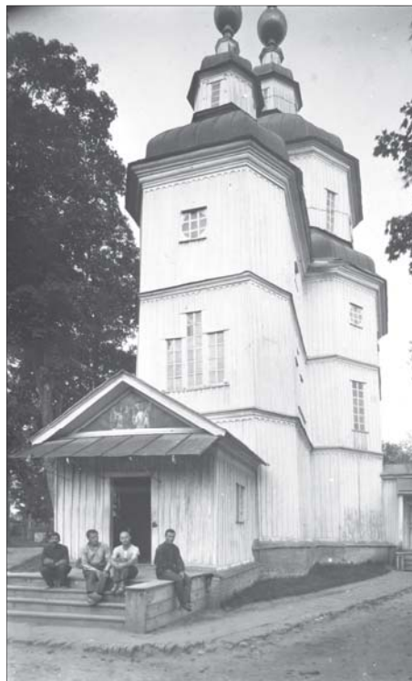
Покровский храм (1759 г.) в г. Зиньков. Внешний вид с запада. Фотография С. Таранушенко. 1928 г.
