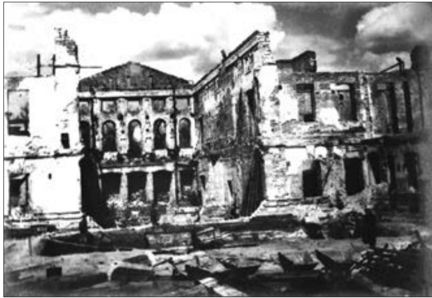
Многие здания Полтавы были разрушены
